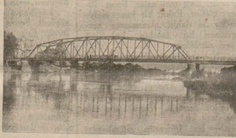
Manavgatta yeni yapılan köprü
